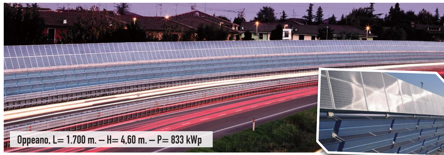
Realisierte Anlagen Borgo Valsugana, L= 40 m. – H= 3,70 m. – P= 12KwP
